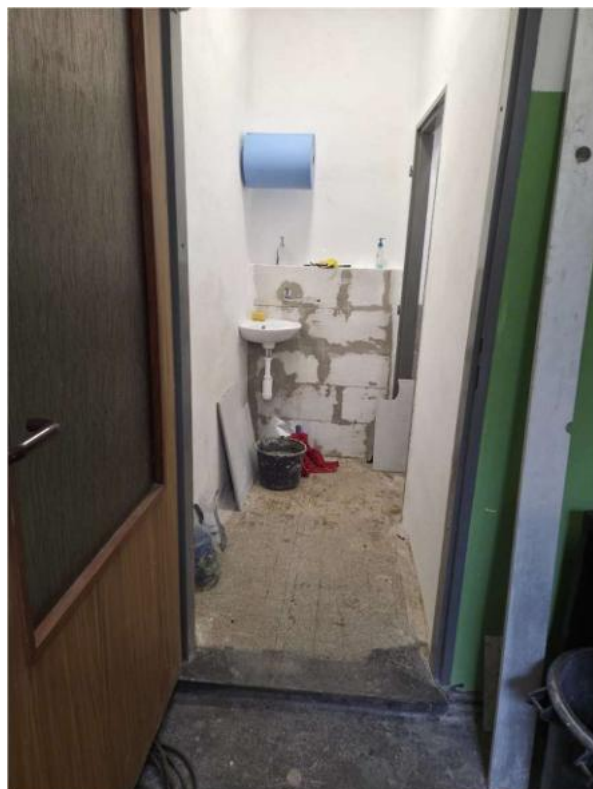
Práce na základně
